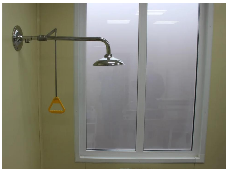
Фото 4. Внутреннее устройство помещений и оборудования здания, предназначенного для исследования инфицированных трупов (с подозрением на инфицирование).
